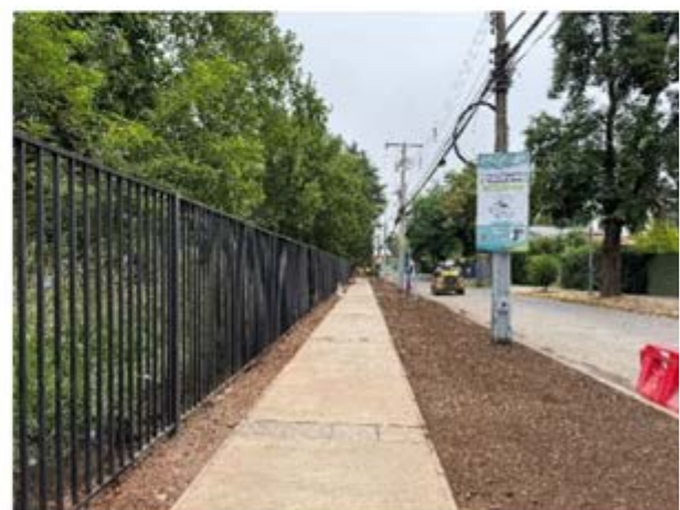
Situación actual por calle Florencio Barrios
