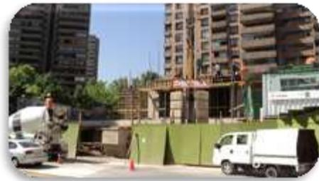
El edificio será una construcción de hormigón armado y estructura metálica con una superficie aproximada de 904,38 metros cuadrados, distribuido en tres niveles. En ellos habrá salas de uso múltiple, oficinas y servicios higiénicos.
